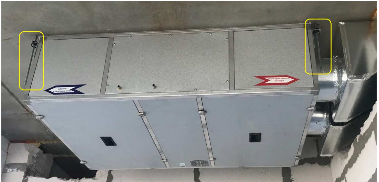
Мал. 3. Приклад кріплення установки до стелі.
