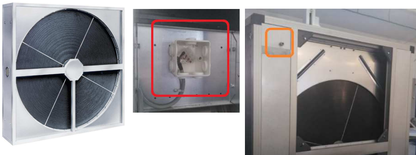
Мал.31. Роторний утилізатор.
