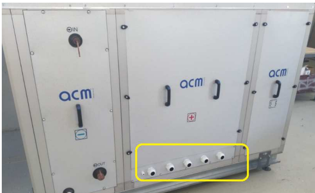
Мал.28. Блок ТЕН - підключення.
