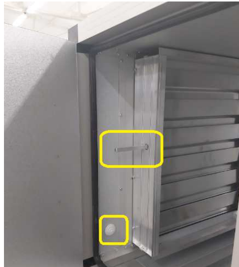
Мал.14. Повітряний клапан установки зовнішнього виконання.
