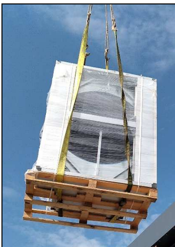
Рис.2. Переміщення вантажу за допомогою текстильних строп.
