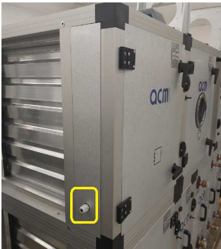
Рис.17. Повітряний клапан установки зовнішнього виконання.
