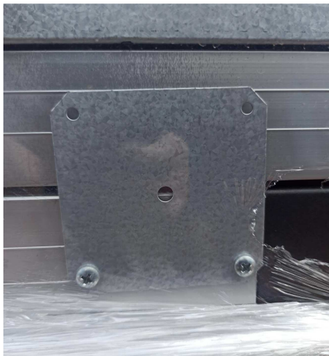
Рис.9 Пластинки для скріплення нижнього і верхнього поверхів.
