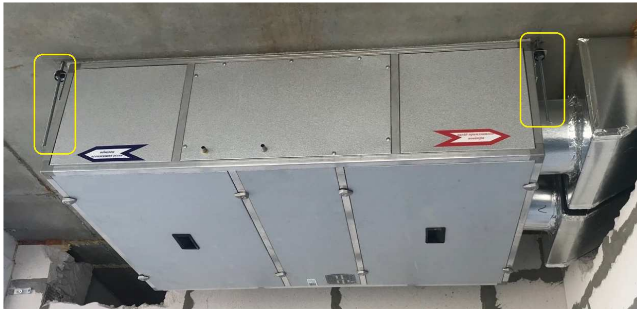
Рис. 8. Приклад кріплення установки до стелі.
